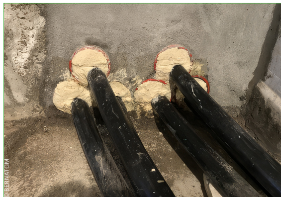
Mousse organo-minérale injectée dans les gaines
