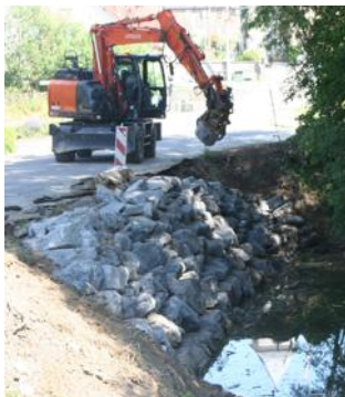
Des travaux d'enrochement sont en cours. Photo Patrice Kihl
